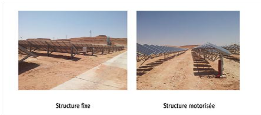
Figure III.7 : Représentation des deux structures utilisées
