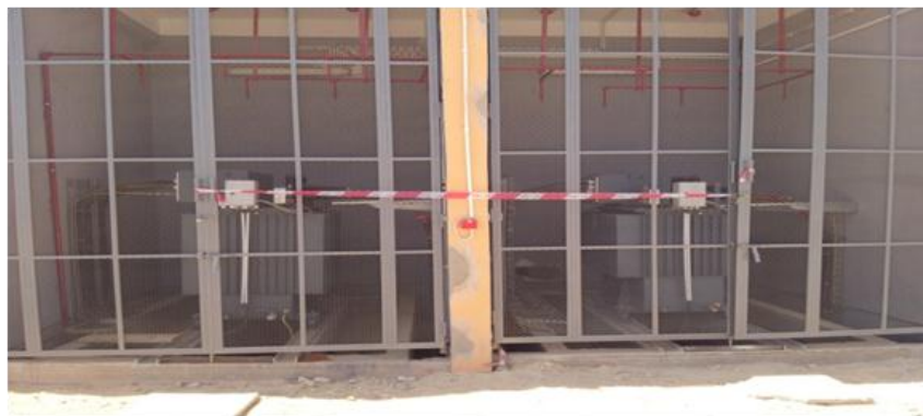
Figure III.11 : Transformateurs MT/BT
