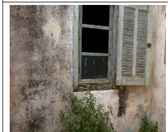
Photo 5-14: dégradation de l'enduit et de la boiserie (sous l'effet de l'humidité). Sources : L'auteur le 17/07/2016
