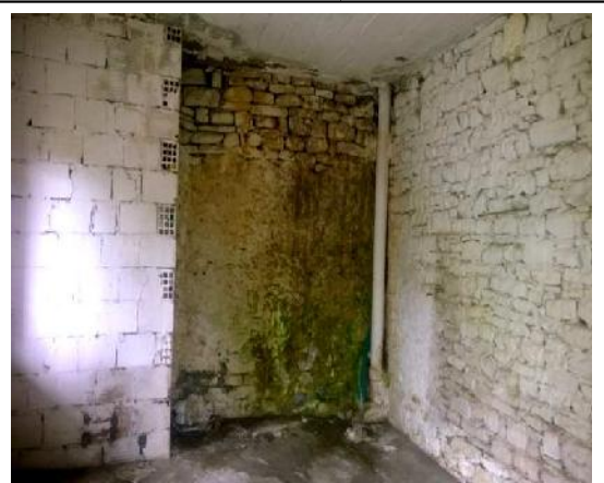
Photo 5-18 : Extension de la chambre à côté du Riadh avec de la brique et un mortier en ciment. Sources : L'auteur le 17/07/2016
