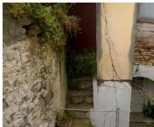
Photo 5-17 : Extension de la construction par de nouveaux matériaux (briques, ciment, porte en fer, peinture vinylique) Sources : L'auteur le 17/07/2016
