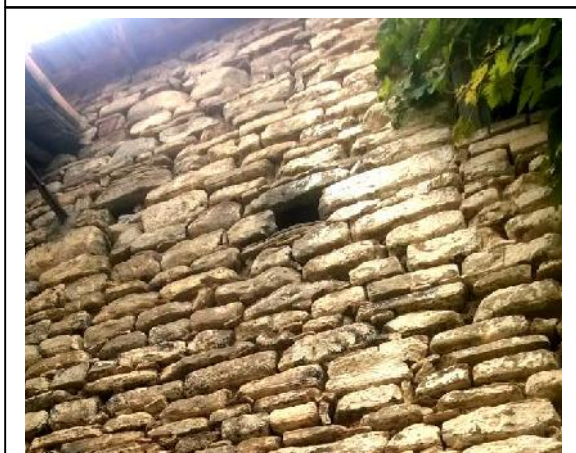
Photo 5-13: dégradation du mortier en terre entre les pierres (sous l'effet de l'humidité). Sources : L'auteur le 17/07/2016
