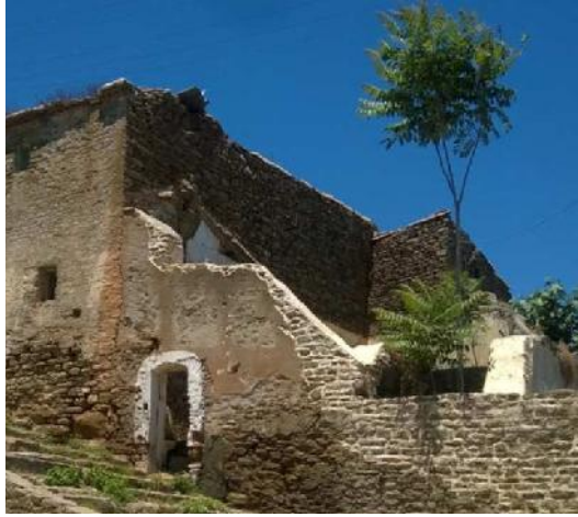
Photo 1-19 : Dégradation du bâti due au manque d'entretien Source : photo prise par l'auteur le 16-05-2016
