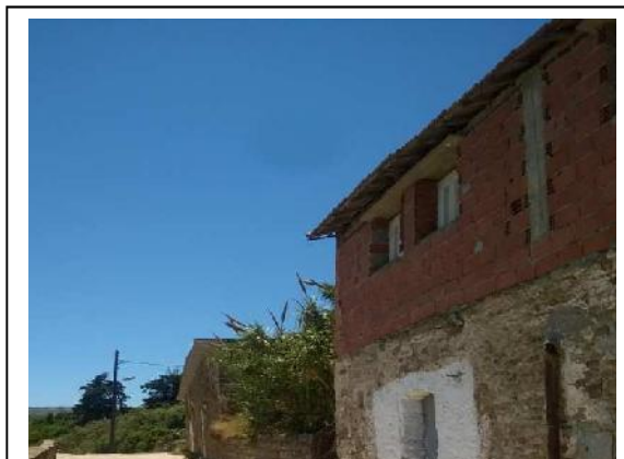
Photo 1-17 : Changement d'usage du bâti vernaculaire Source : photo prise par l'auteur le 16-05-2016
