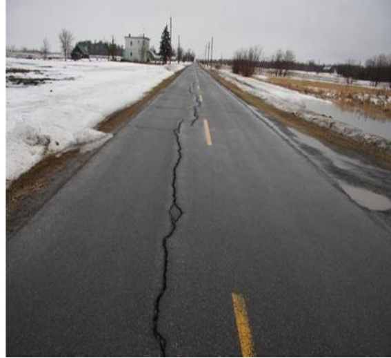
Figure IV-3 : gel de sol et ses effets sur les chaussées. (John Loudon McAdam)
