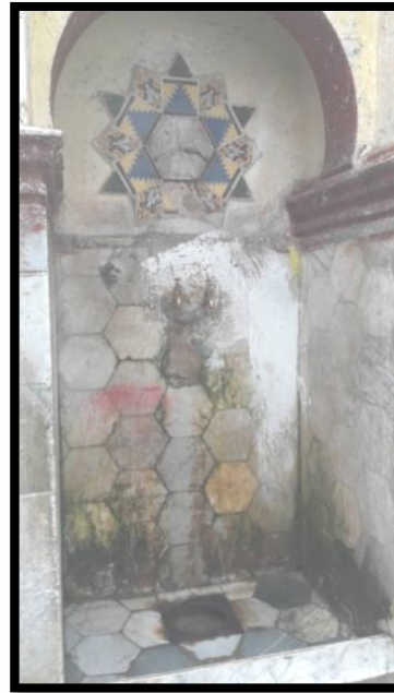
Figure 3:Source: la dégradation de la faïence.
