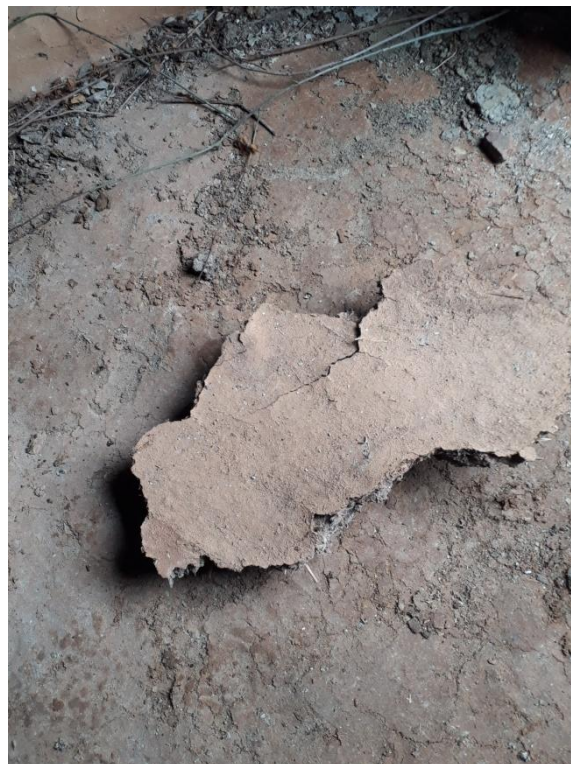
Figure 39: morceau de revêtement interieur en Toube.
