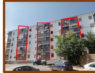
Figure 110: Vue sur les barres sans coursives. Source : auteurs
