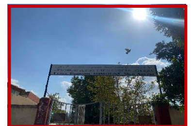
Figure 132: Vue sur l'école MIMOUN Med AREZKI. Source : auteurs
