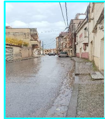
Figure 73 : Vue sur la rue AMARI. Source : auteurs
