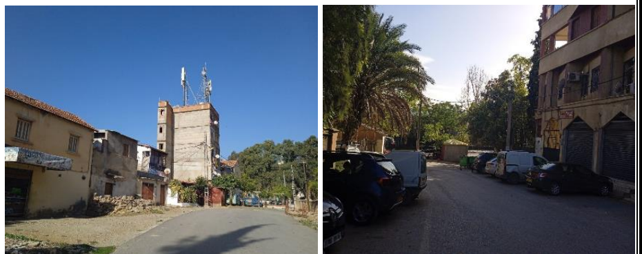
Figure 97: Vues sur l'état de la rue tapisserie. Source : auteurs
