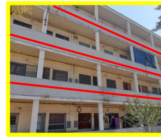
Figure 108 : Vue sur les coursives. Source : auteurs
