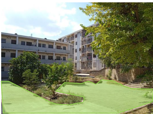
Figure 118: Vue sur le seul espace de rencontre dans la cité le CADI. Source : auteurs
