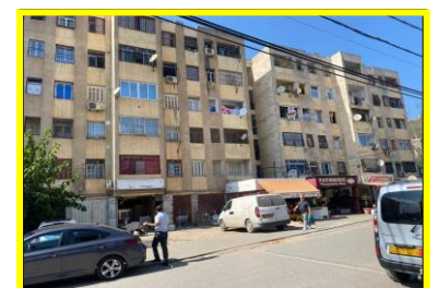
Figure 43 : : Vue sur l'habitat collectif. Source : auteurs
