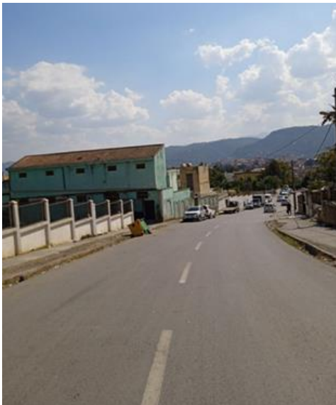
Figure 202: Voie KESRI avant intervention . Source : auteurs
