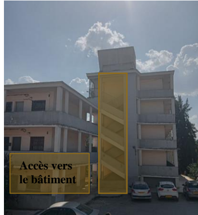
Figure 115 : Vue sur l'escalier extérieur Source : auteurs
