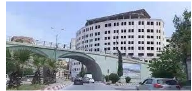
Ville commerciale Figure 5: La tour. Source : Auteurs
