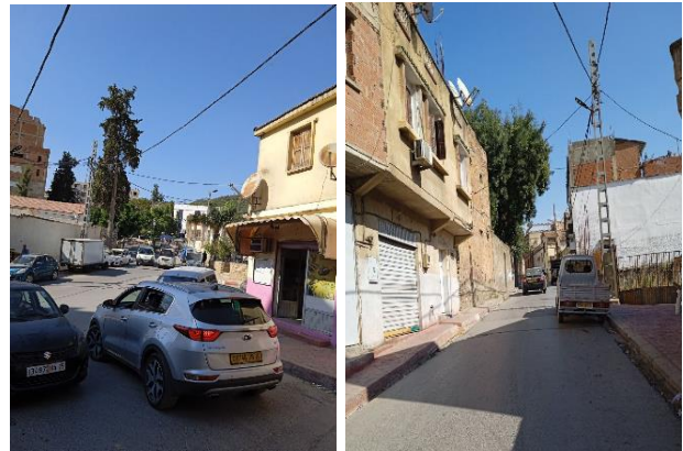
Figure 97 : Vue sur l'état de la rue AMARI. Source : auteurs
