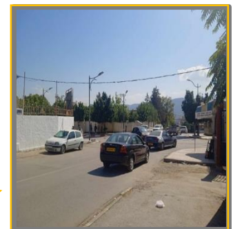
Figure 32: Vue sur l'intersection n° 01. Source : auteurs
