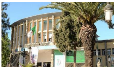
Figure 9 : Maison de la culture. Source : Auteurs
