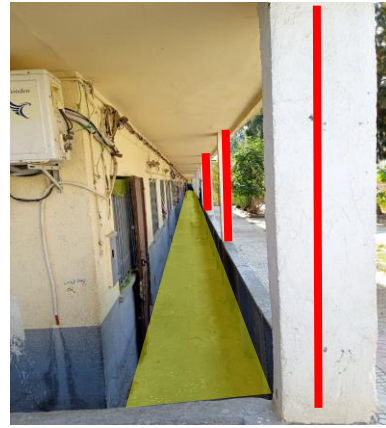
Figure 114: Vue sur les poteaux de renforcement. Source : auteurs
