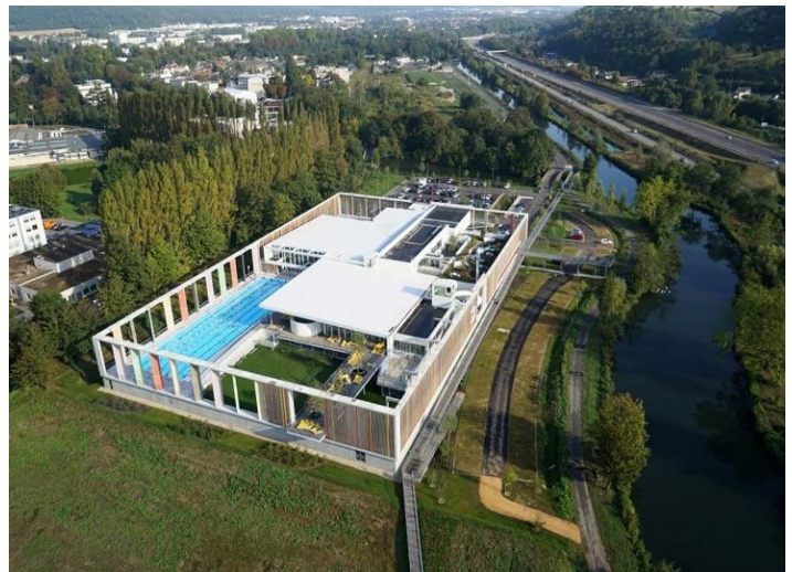
Figure 284: vue sur le complexe intercommunal CASEO source : https://louviers.circonscription.ac-normandie.fr/IMG/pdf/projet_pedagogique_caseo_2015_2016.pdf
