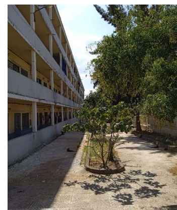
Figure 117: Vue sur une cour intérieure. Source : auteurs
