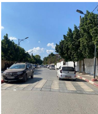
Figure 199 : Voie BOULILA avant intervention source : auteurs
