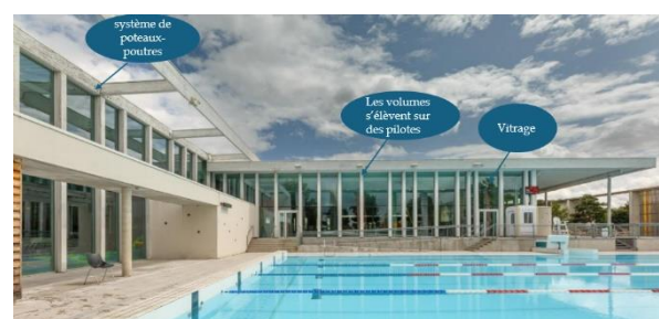
Figure 303: Le système constructif Source : archdaily.com traité par auteurs
