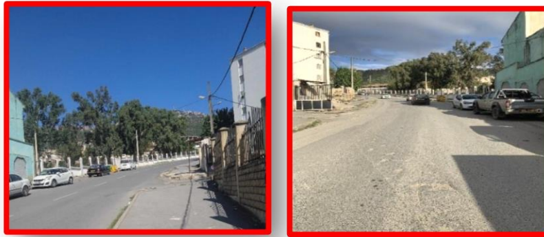
Figure 66: Vues sur la rue KESRI Amar.
