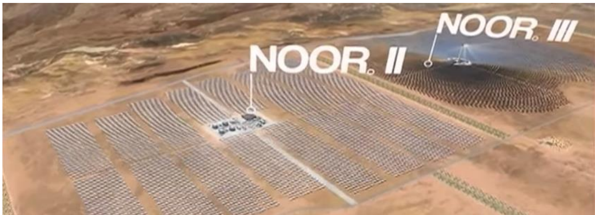
Figure V : Centrale NOOR au Maroc.
