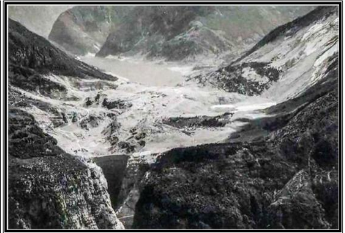
Figure 1.20 : Barrage du Vajont après le mouvement de Terrain du 9 octobre 1963
