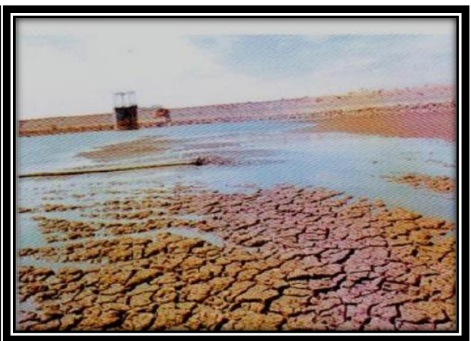
Fig 1.18: Envasement du barrage de BAKHADDA (TIARET)
