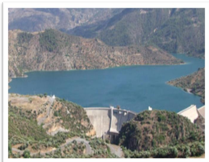
Figure 1.2 : Barrage Tichy-haf (Bejaïa)
