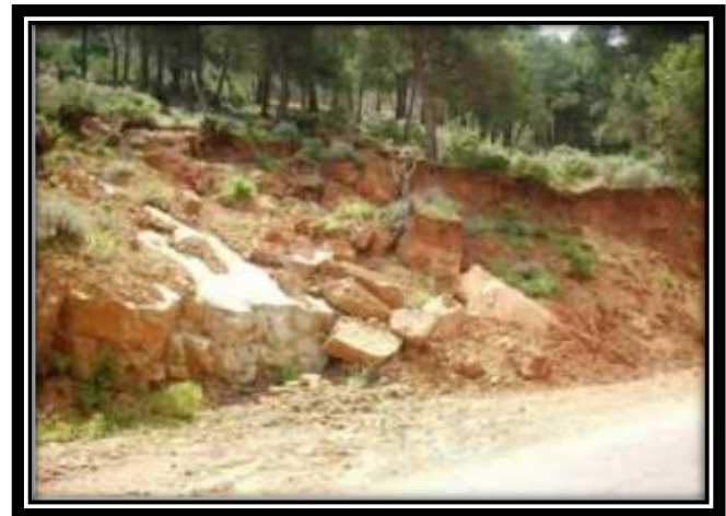
Figure 1.14: Exemple d'un glissement plan, Ténès, Algérie
