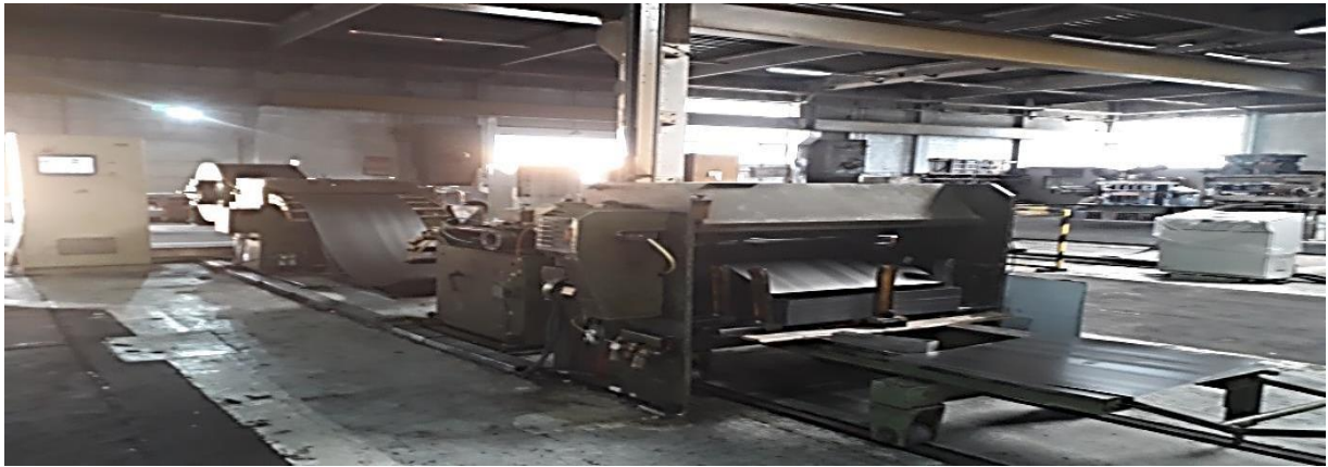
Figure III-14 : Le passage de la bobine déroulée
