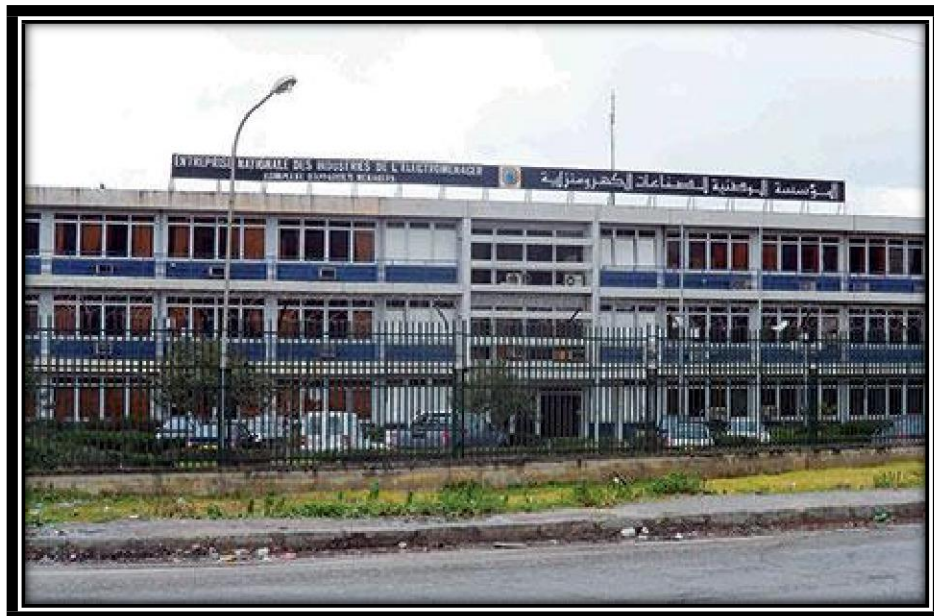
Figure 1: Siège de l'Entreprise Nationale des industries électroménagères
