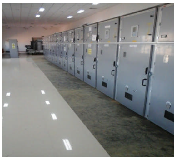
Fig IV- 8: Présentation des cellules unigear ZS 3.2
