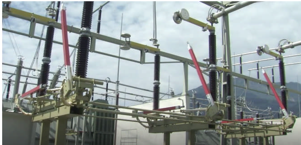
Fig I- 15: sectionneurs.
