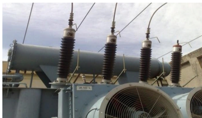
Fig IV- 4 : Éclateurs placés sur les pôles HT.
