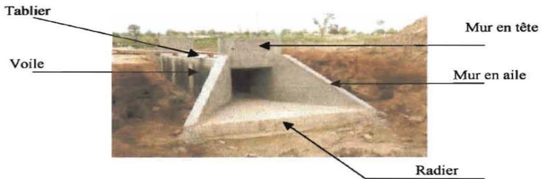
Figure 1.10 : Schéma d'un dalot cadre.
