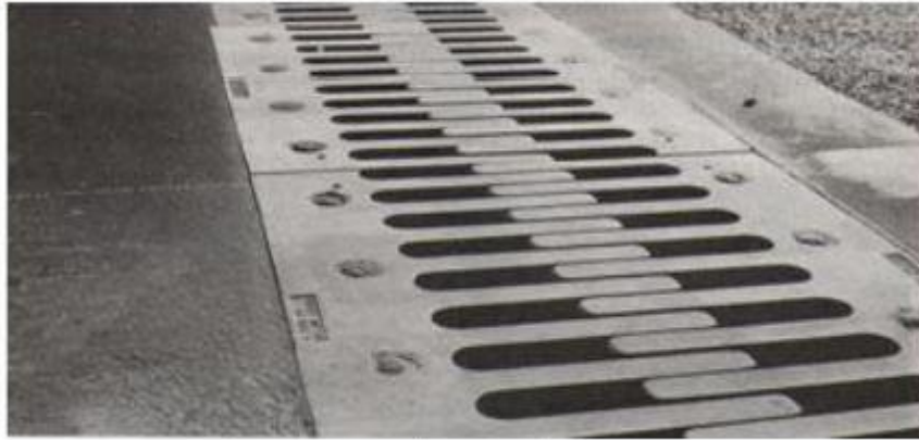
Figure 10.7: Joint de chaussée.
