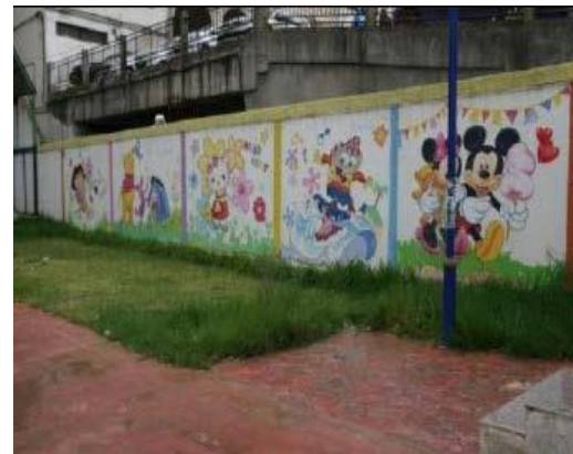
FigureII-22 : Mur de la partie Aire de jeux. Source : Auteur
