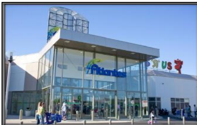
FigureIII-10 : Centre commercial Les Atlantes, France Source : http://www.google.dz/search?biw=1366&bih=588&tbm=isch&sa=1&ei=-Centre+commercial+Les+Atlantes
