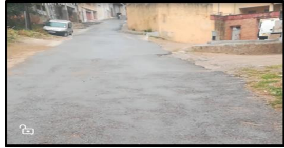
Figure 67: rue principale à Taourirt Mimoun.
