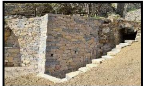
Figure 121 Mur de pierre en maçonnerie de moellon source google image
