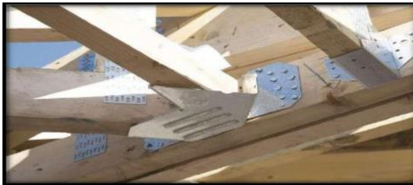
Figure 119 type de liaison Connecteurs métalliques pour travée en bois source Google image.
