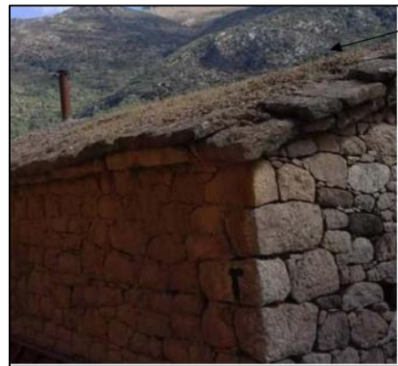
Figure 24 : murs réalisés en pierre. Source : Google image
