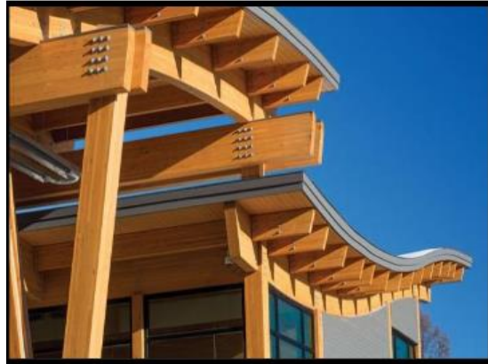
Figure 107 Le Bois lamellé collé. Source google image
