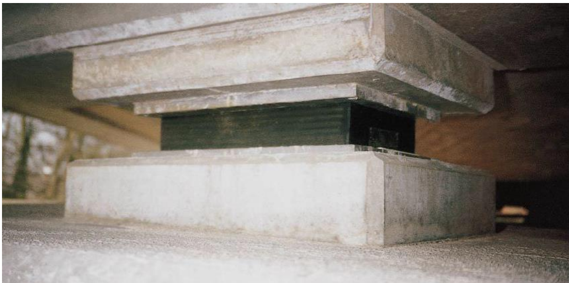
Fig.XII .1 : Appareils d'appuis
