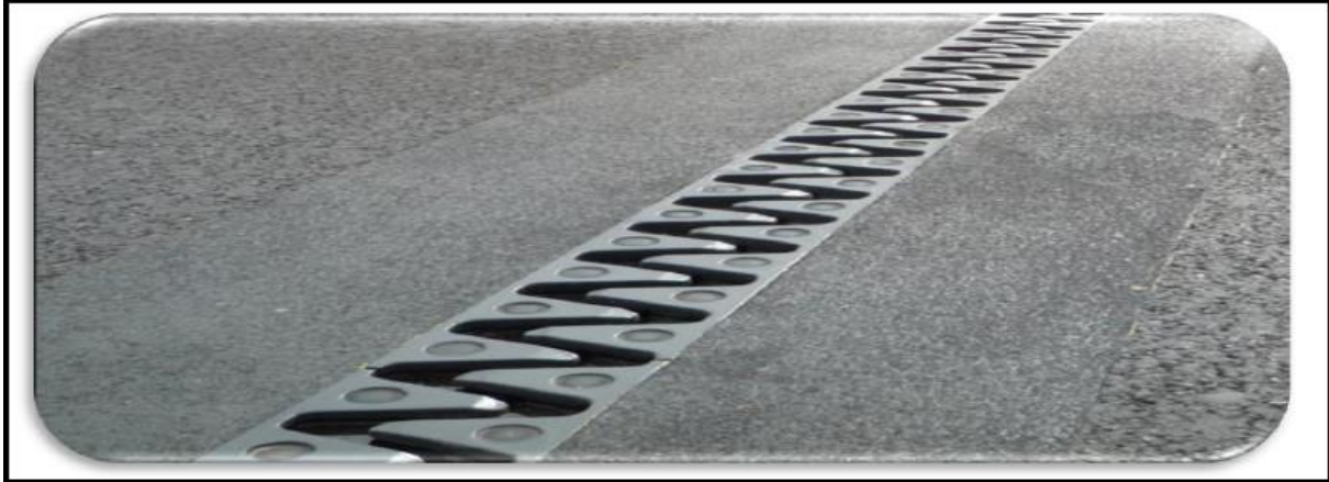
Fig.XII .7: Joint de chaussée
