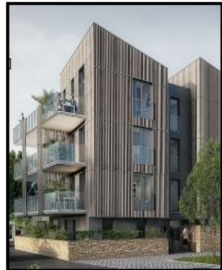
Figure 61: Revêtement en bardage/ Source:
