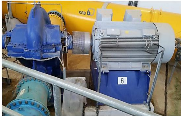
Figure.III.6. Pompe à volute à plan de joint axial KSB.
