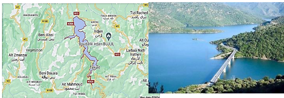
Figure III.1. Localisation géographique et vue du barrage de TAKSEBT.
