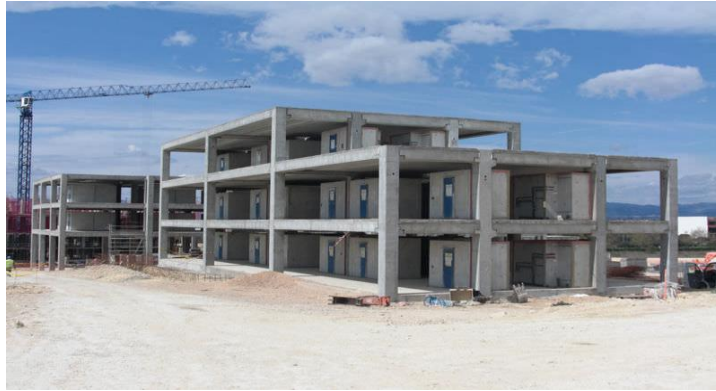
Figure I.3 .Contreventement assurent par portique
