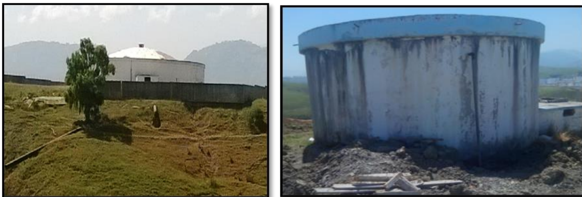
Figure III.10. Réservoir de capacité 5000m 3
