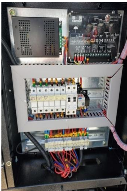
Figure III.6. Armoire électrique du groupe électrogène 126 KVA[25].
