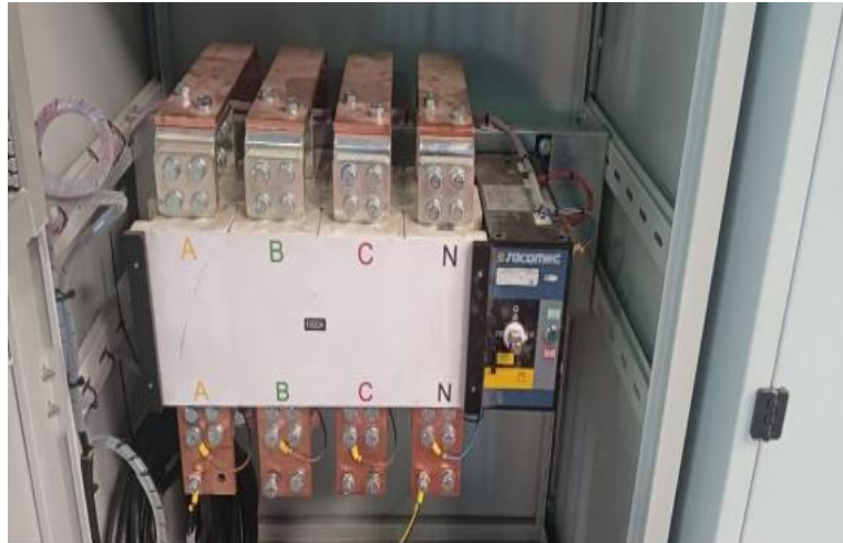
Figure II.16. Exemple d'un inverseur de source[22].
