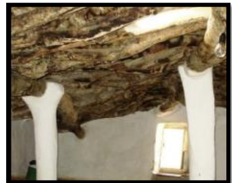
Fig 66 : Asfalou (Ouverture de la toiture)
