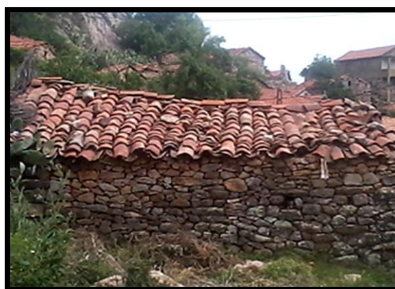
Fig 58 : Charpente de maison du village Voumensour
