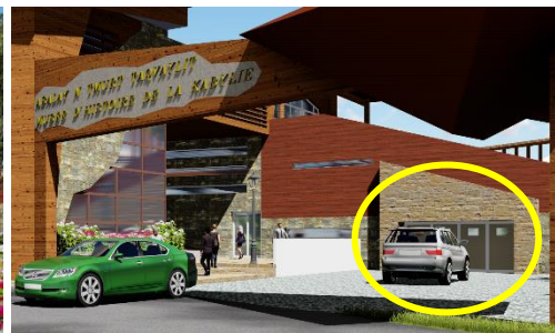
Fig 16 : Accès Mécanique au parking sous-terrain
