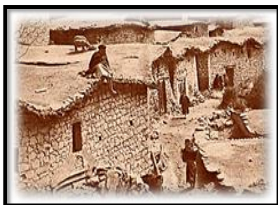
Fig 57 : Toiture terrasse village Agouni Guegherane
