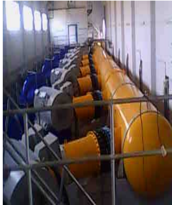
Vue sur les 06 moteurs (5012m 3 /h) de la station de pompage
