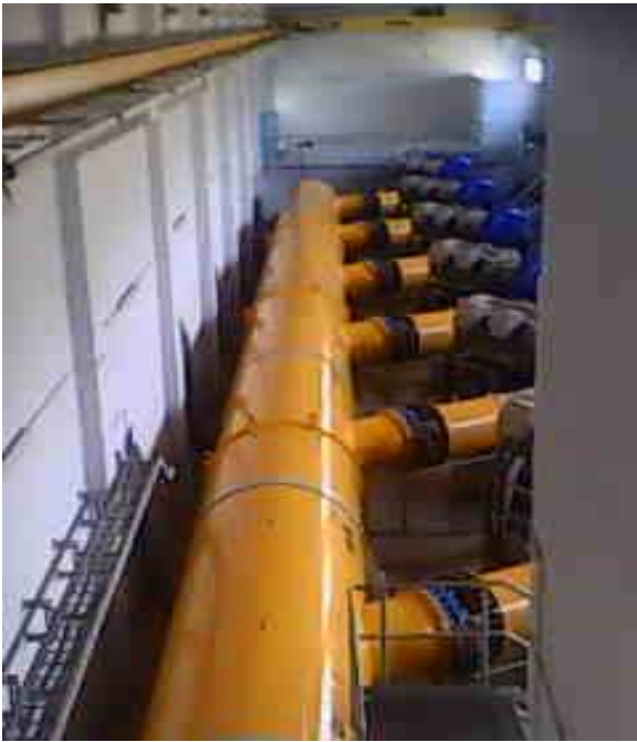
Vue sur les 06 moteurs (5012m 3 /h) de la station de pompage
