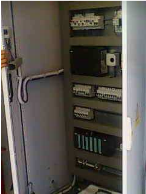
Armoire des raccordements électriques
