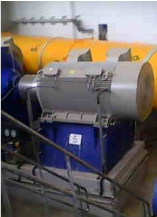
Vue sur les 06 moteurs (5012m 3 /h) de la station de pompage
