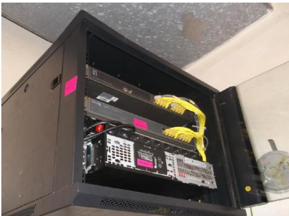
**Fig. I.14** : Armoire de brassage du le bloc B.
