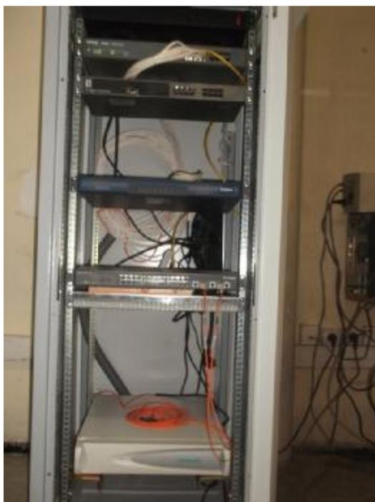
**Fig. I.15** : L'armoire de brassages au niveau de la C.A.
