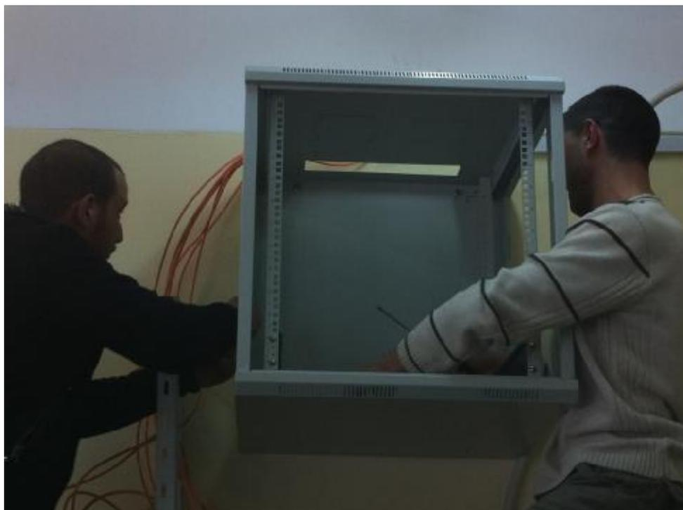
Avant toute chose, on doit placer les armoires dans un endroit précis (sécurisé et aéré). Soit fixé au sol ou sur le mur.
