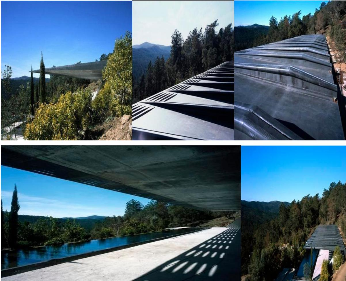
***Figure 1.5 : Panneau préfabriqué en béton fibré [13]***
