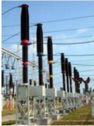
Figure I.20a : Disjoncteur SF6 monophasé.
