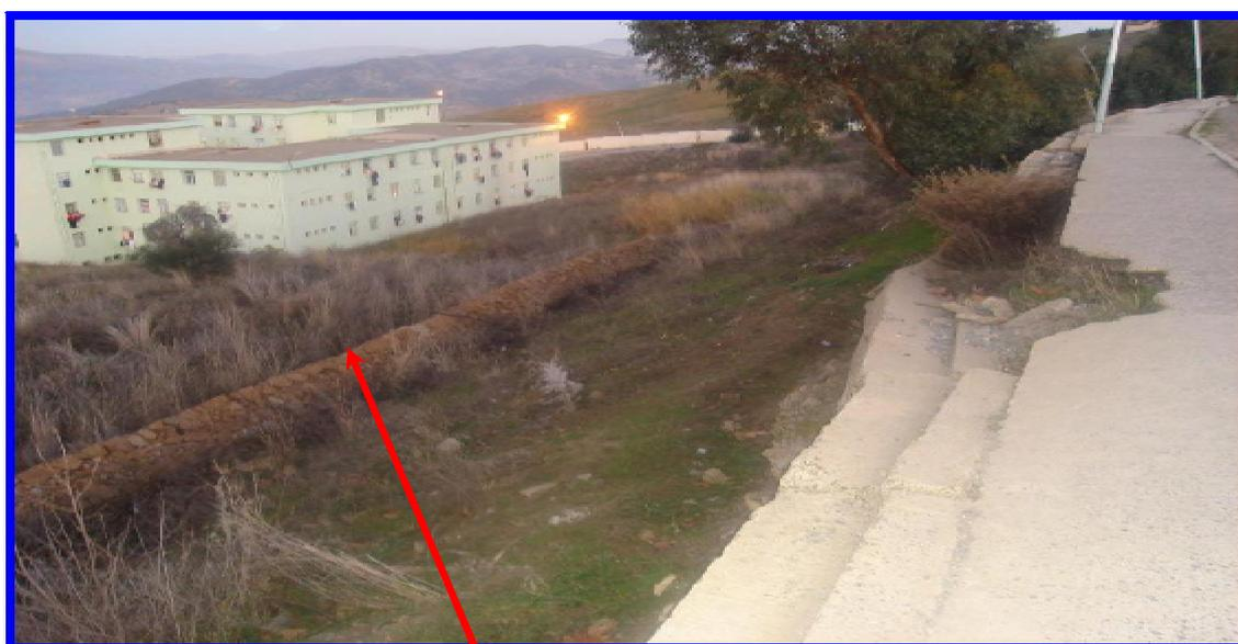
**Figure. IV. 3. Renversement du gabionnage.**
