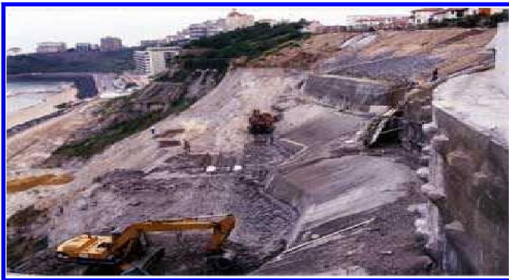
**Figure. III.1 : Phase terrassement pour stabilisation d'une pente.**
