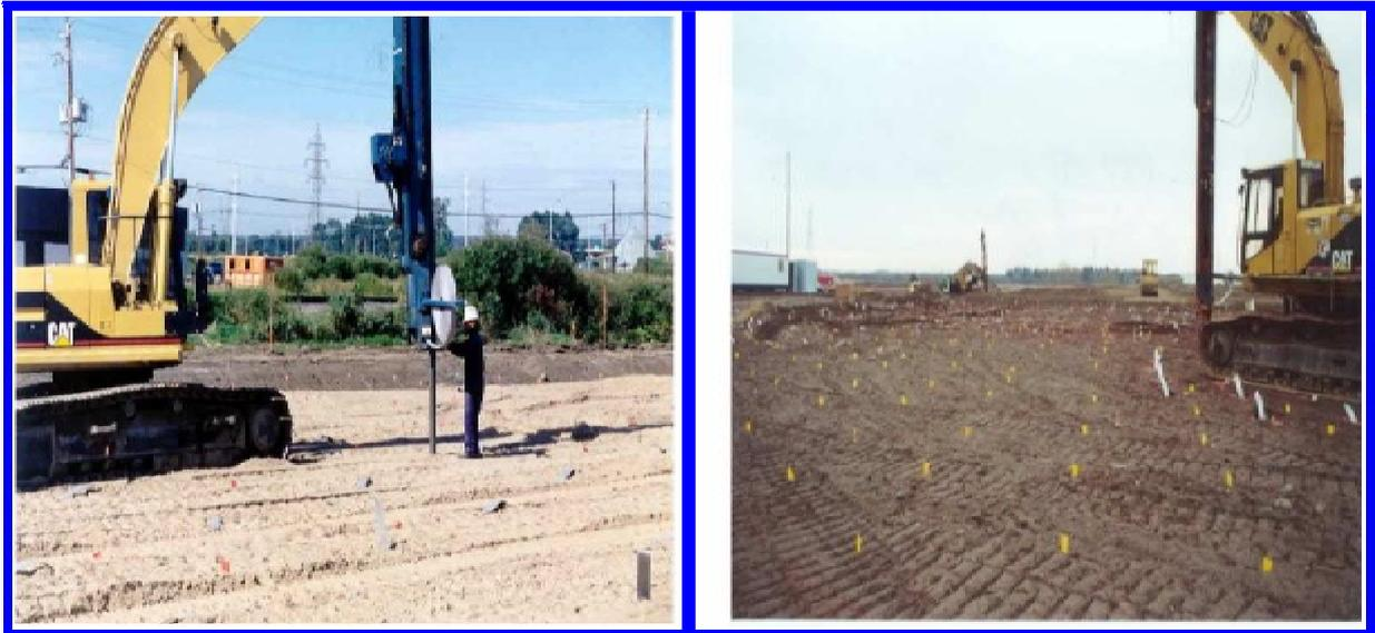
**Installation des drains verticaux****Chantier de réalisation des drains verticaux
