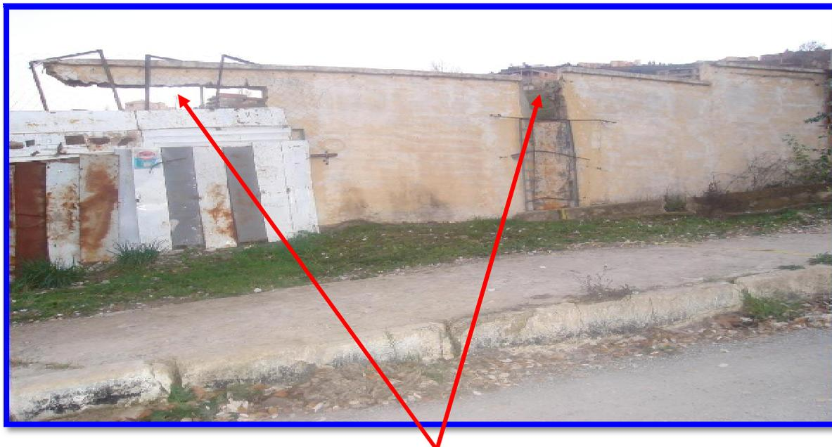
**Figure. IV .4. Murs de clôture dégradé et déplacé.**
