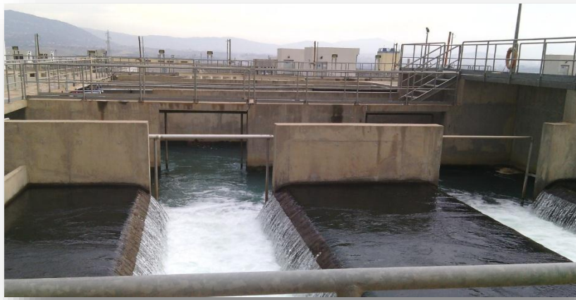
Figure I.2 : Ouvrage d'entrée.
