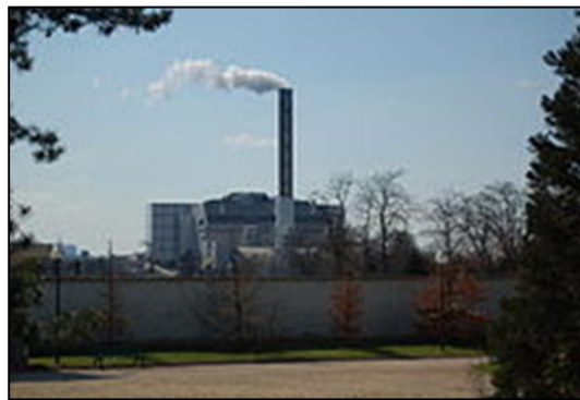
Figure I.12 : Incinérateur de déchets situé à Saint-Ouen. Source: https://fr.wikipedia.org .
