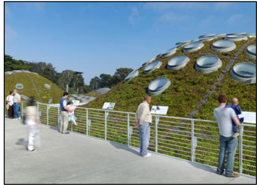
Figure II.25 : Cellules photovoltaïques sur le toit de l'académie. Source: http://www.google.img/ASC .
