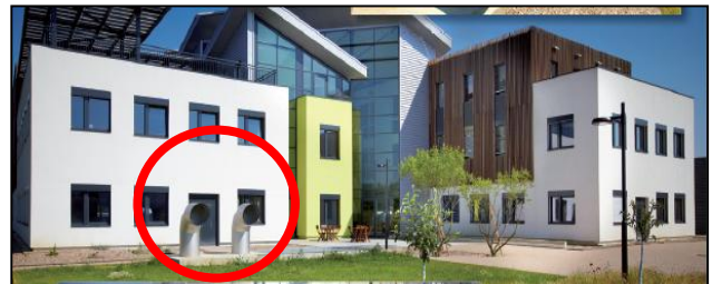
Figure II.11 : Chauffage géothermique. Source : http://www. Roche .PDF .
