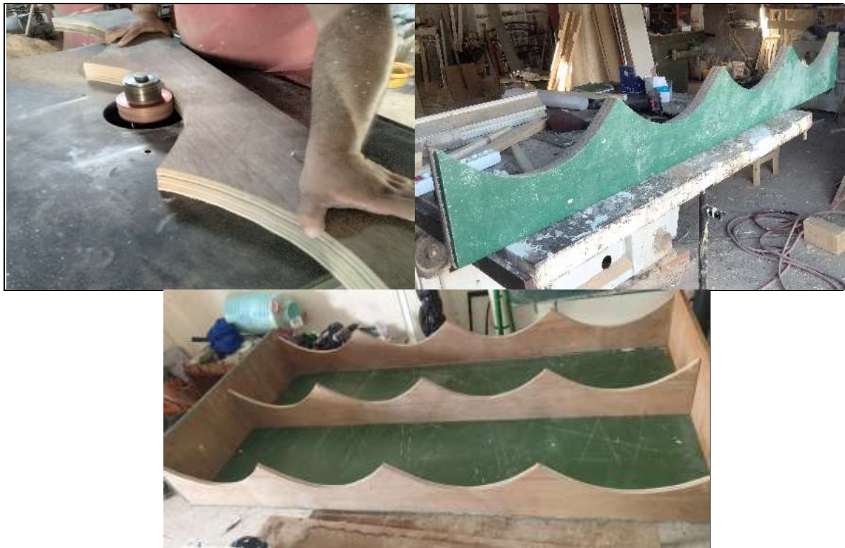
Figure 5.6 : Etape de réalisation de cadre de support pour la structure cylindrique équivalent.
