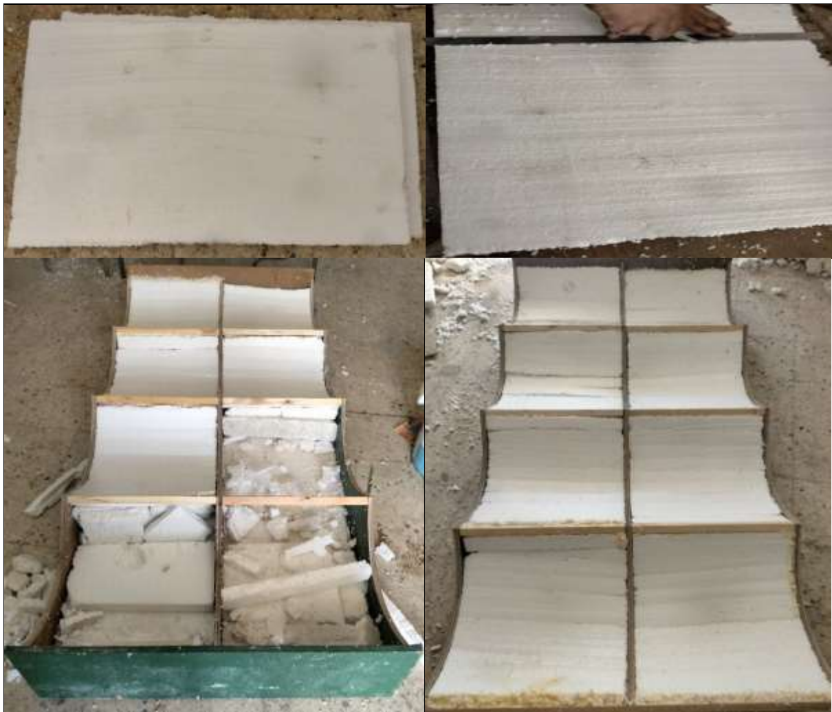
Figure 5.7: Étapes d'installation des panneaux en polystyrène .
