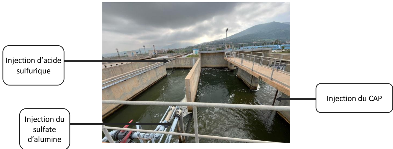
Figure I-7 : Chambre de Mélange
