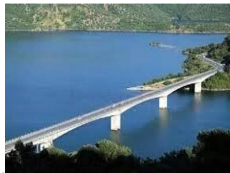
Figure I-2 : Barrage de Taksebt
