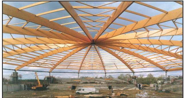
Figure III.29 : Structure en lamellé-collé.
