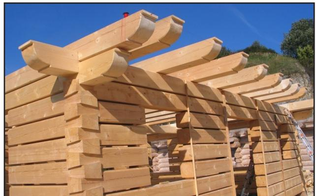
Figure III.27 : Structure en bois massif.
