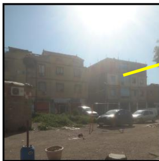
Figure 38: habitat individuel (Atelier de mécanique en RDC) Source : Auteurs
