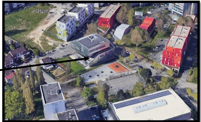
Figure 73: environnement immédiat Source : www.archdaily.com
