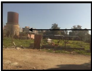
Figure 49: Réservoir abandonné Source : Auteurs
