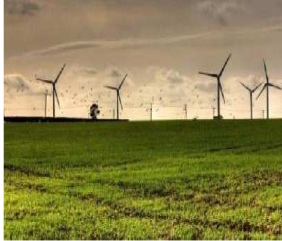
Fig I.3 Parc éolien terrestre.
