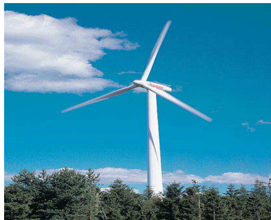
Fig I.2 Eolienne sur un terrain individuel.
