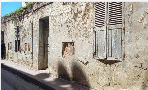
Figure 69 acte de pillage: insertion des vestiges sur les façades du bâti colonial /source: auteur
