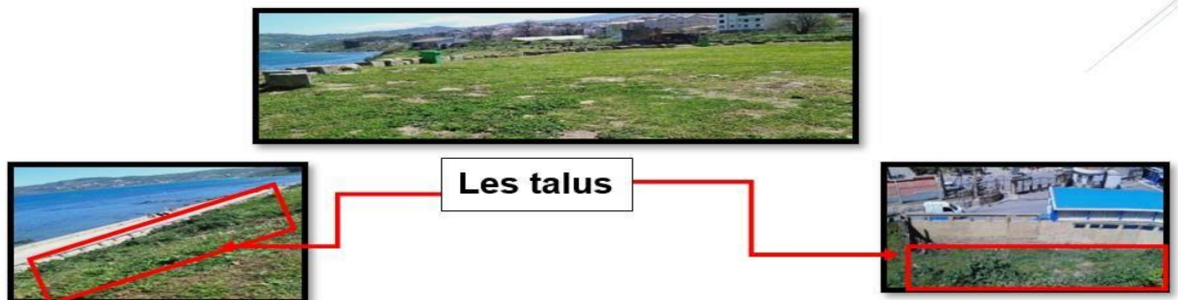
Figure 67 le manque de végétal à l'intérieur du site archéologique et surtout sur les talus provoque des risques de glissement Source : auteur
