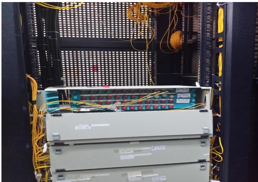
Figure III.9 : L'armoire optique.
