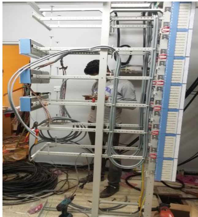
Figure III.18 : L'armoire du répartiteur.
