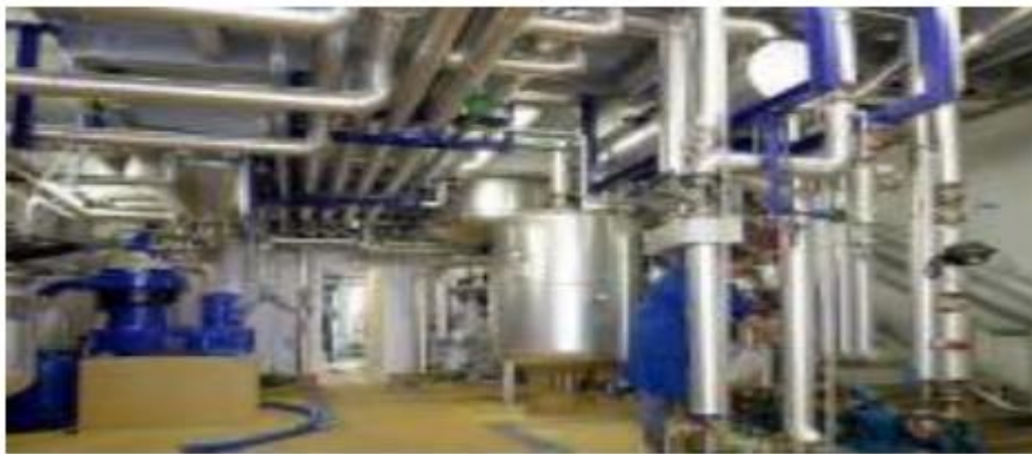
Figure II.1 : Station de raffinage d'huile
