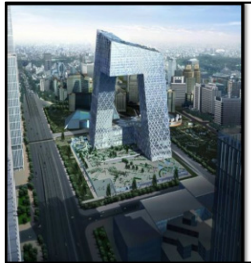
Figure112 : Siège CCTV avec son jardin Source : [http://3.bp.blogspot.com/WMkgMON]
