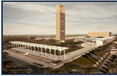
Figure 18: Vue sur la grande mosquée
