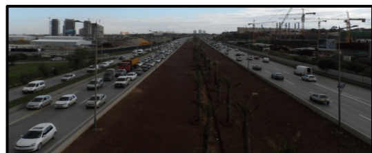
Figure 34 : Vue sur la RN 11 Source : prise par l'auteur
