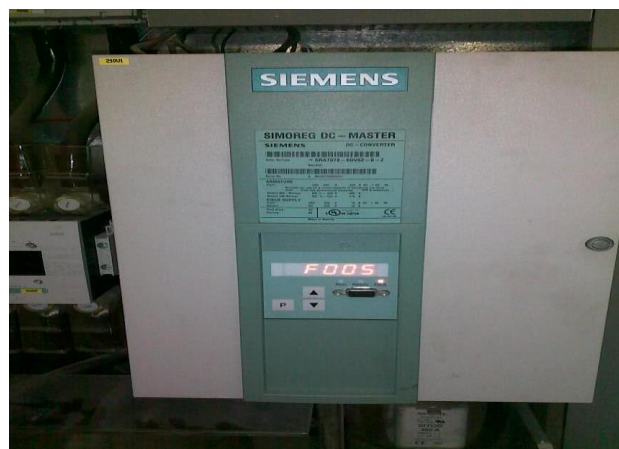
Figure III.12 : Variateur de vitesse SIMOREG DC MASTER.
