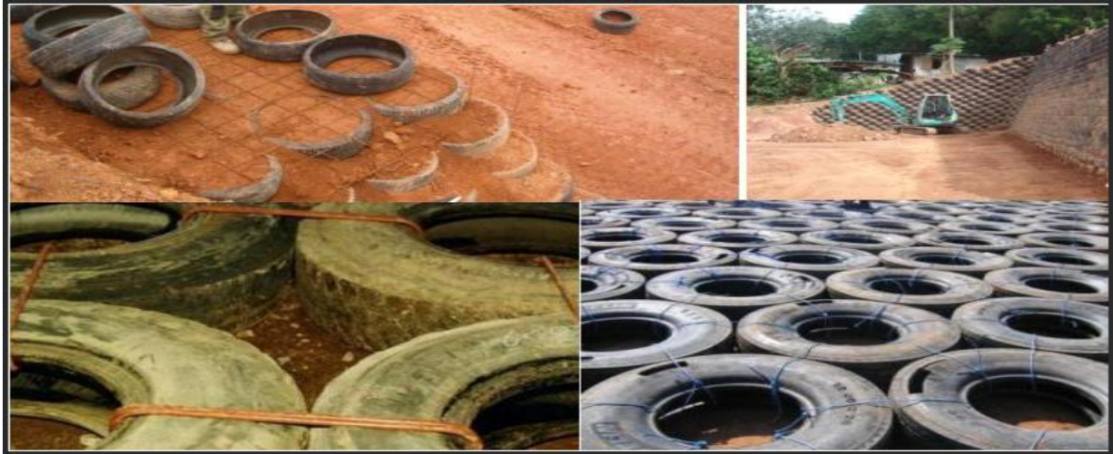
Figure II-2 : Amélioration de la cohésion par treillis soudé, attaches métalliques ou en nylon[2]
