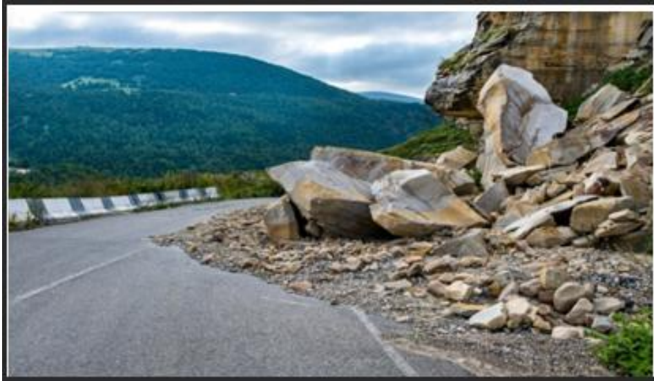
Figure I-4 : Éboulement et chutes de pierres [7] (Béjaia-Algerie)
