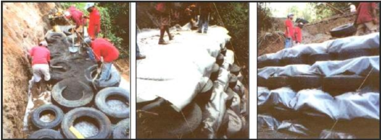
Figure II-2 : Amélioration de la cohésion par treillis soudé, attaches métalliques ou en nylon[2]
