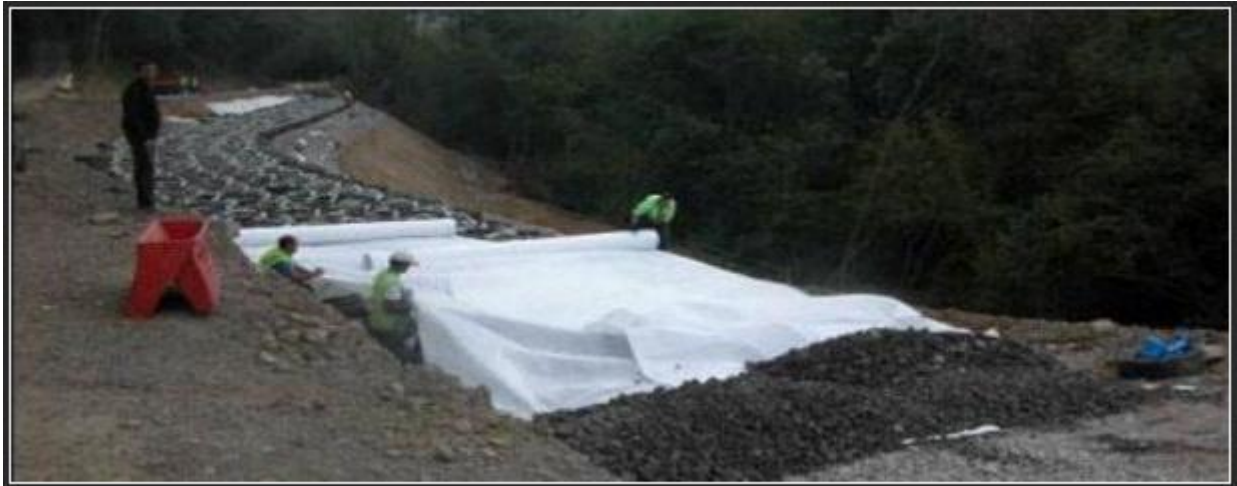
Figure II-4 : Utilisation du Pneu-sol en remblai allégé.[2]
