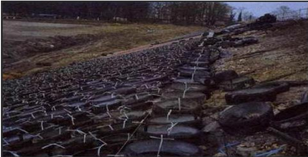
Figure II.8 : Protection des berges contre l'érosion d'un fleuve [4]
