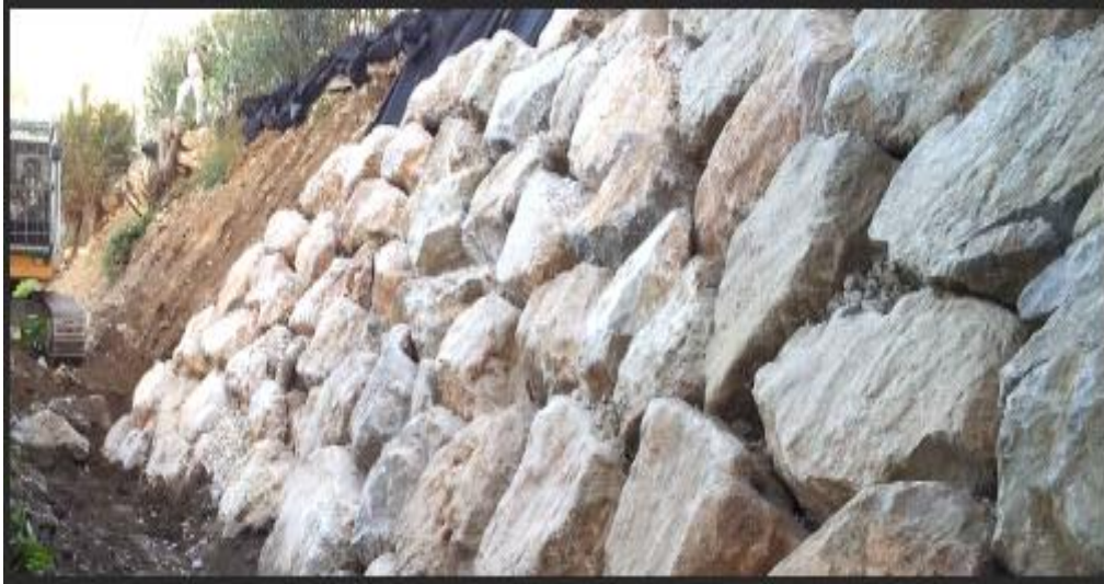
Figure II-13 : Méthode de l'énrochement
