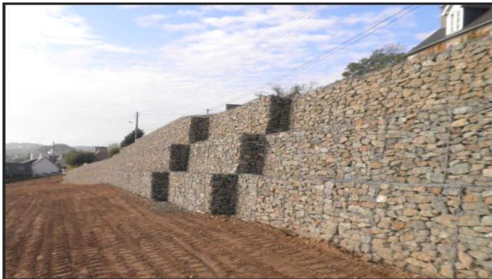
Figure II-12 : Mur en gabion
