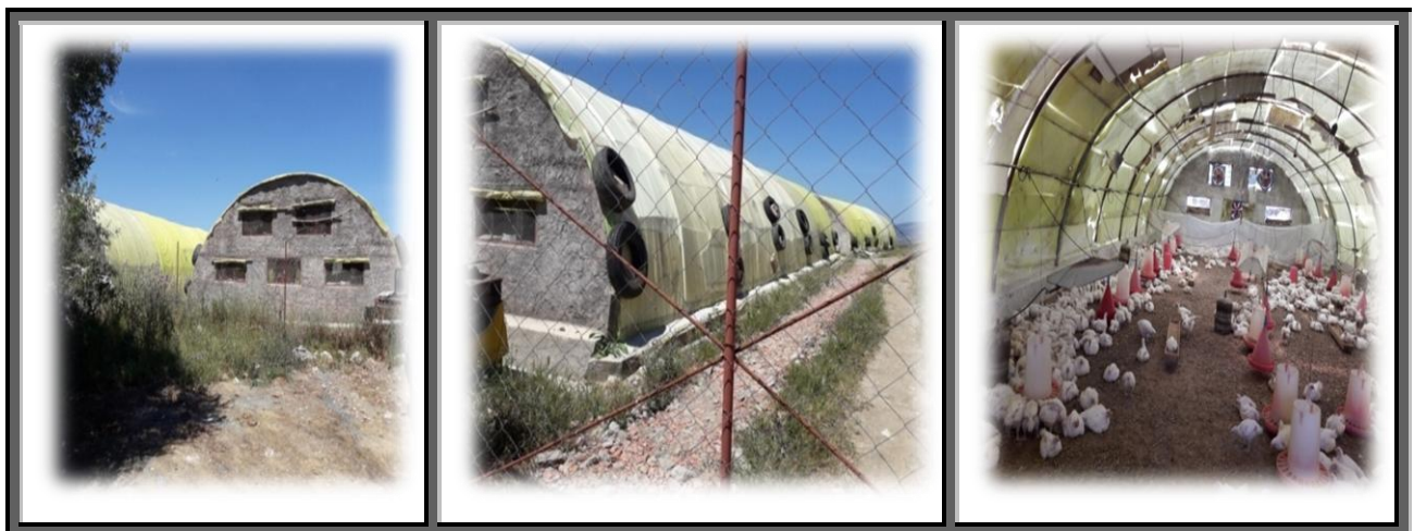
Figure 11 : Bâtiments d'élevages de poulets de chair dans la daïra de Mekla (original 2021)
