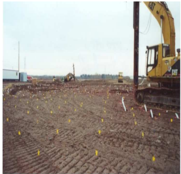
Figure II.16 : Chantier de réalisation des drains verticaux
