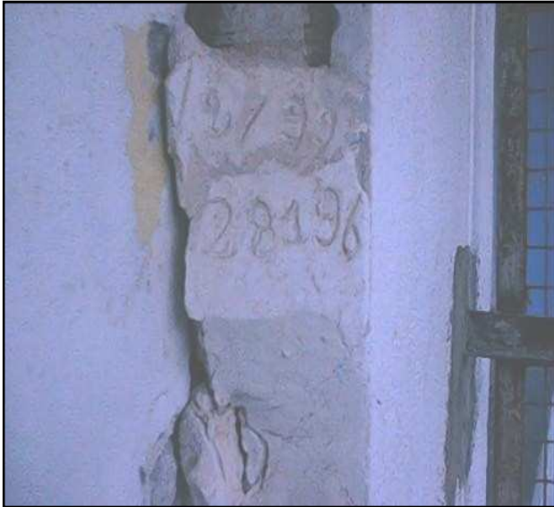
Témoins en plâtre mis en place le 01/96 et 01/97 (éloignement du joint entre deux blocs de) [11]
