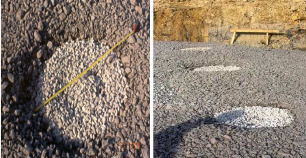
Figure II.21 : Colonnes ballastées réalisées par voie sèche.
