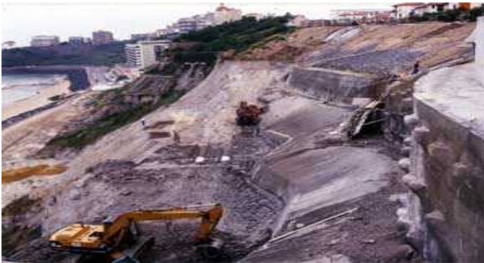
Figure II.1 : Phase terrassement pour stabilisation d'une pente.
