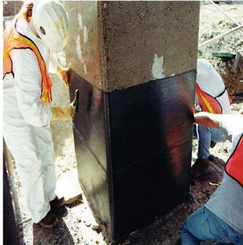
Figure I.19 : Confinement des colonnes par stratification directe [5]
