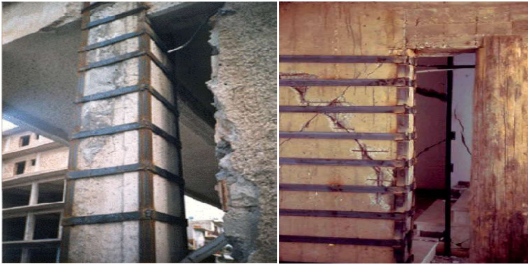
Figure I.12 : Chemisage en acier [5]
