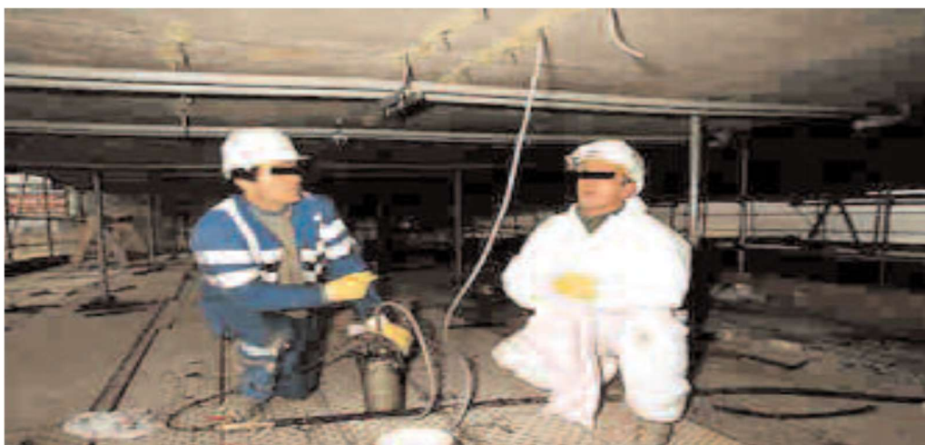
Figure I.1 Nettoyage d'une fissure avec une brosse métallique [6]
