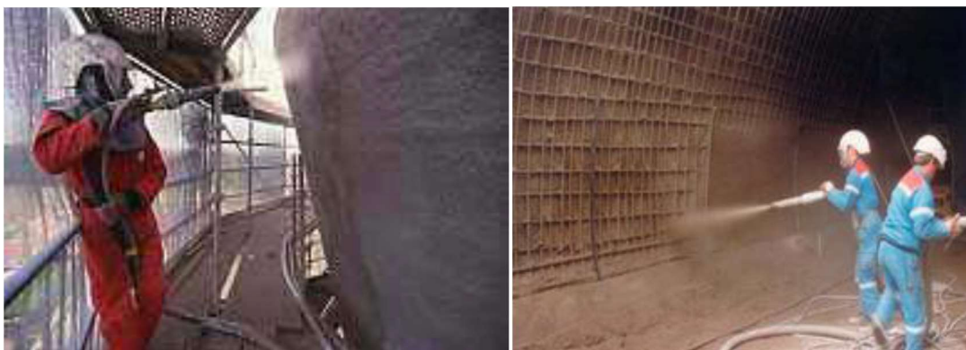
Figure I.7 : Renforcement au moyen d'un béton projeté [6]
