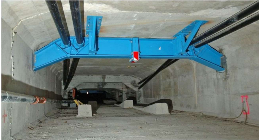
Figure I.10 Précontraintes additionnelles [5]
