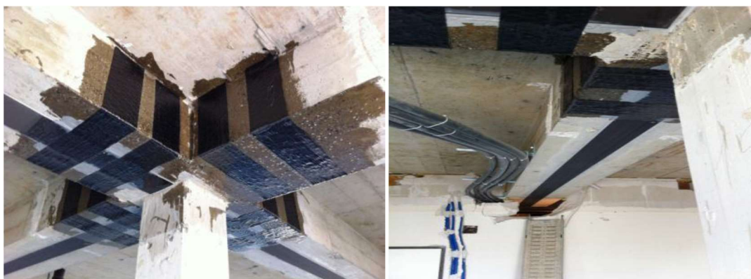
Figure I.15 : Poutres en BA renforcées par matériaux composites. [5]
