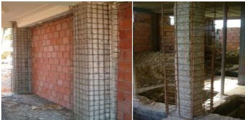
Figure I.11 : Préparation des poteaux pour le chemisage en béton armé [5]
