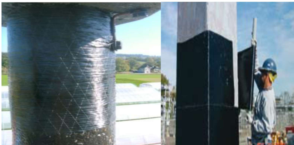
Figure I.14 : Poteaux en BA confiné par matériaux composites [5]
