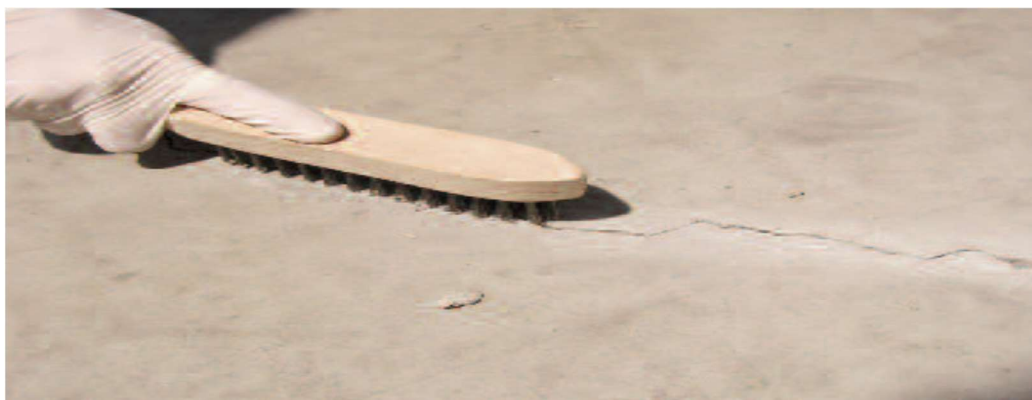
Figure I.1 Nettoyage d'une fissure avec une brosse métallique [6]
