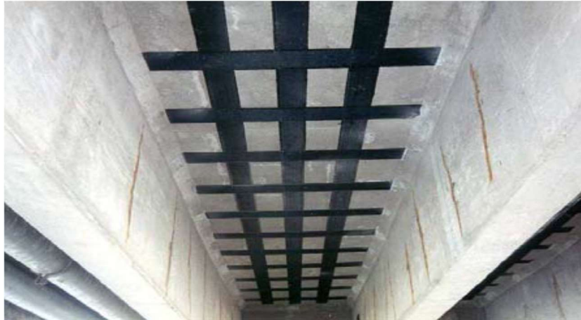
Figure I.17 Renforcement d'une dalle de pont [5]
