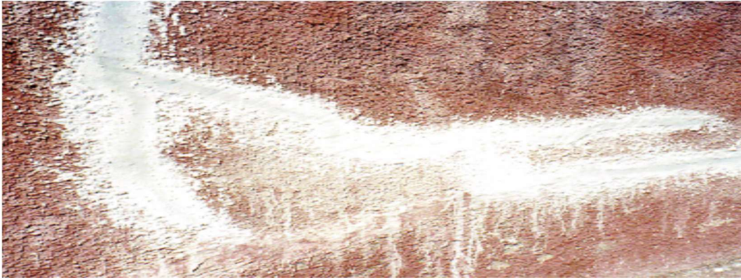
Figure I.4 Calfeutrement de fissures à l'aide d'un mortier à base de liants hydrauliques [6]
