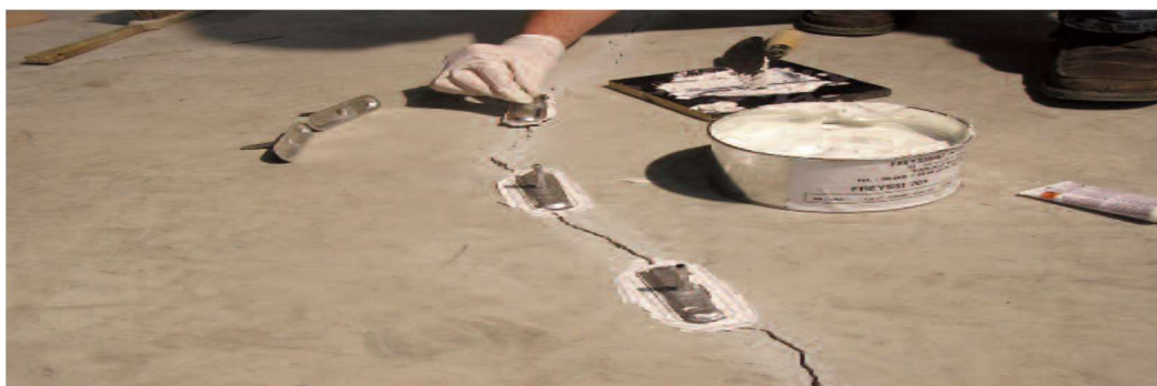
Figure I.3 Fissure en cours de cachetage [6]
