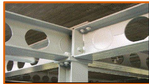
*Figure123 : Assemblage Boulonnée*
