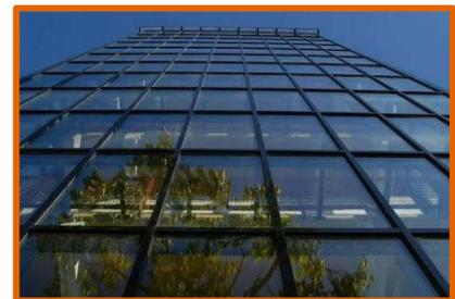
Figure128 : les panneaux d'un mur rideau. *Source* : cour matériaux S9
