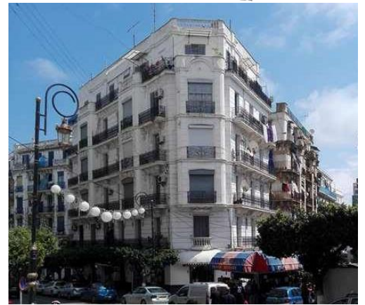
Fig 46 : Immeuble de rapport Rue Didouche M. Alger. Source : Les auteurs.
