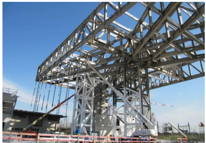
Fig 109 / 110 : Image en cours de construction des piles et des poutres métalliques. Source : www.batiactu.com .
