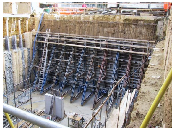
Fig 104 : Mise en œuvre de voiles périphériques. Source : www.wolftech.be
