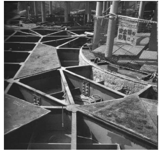
Fig 76 : Montage des planchers alvéolés. Source : Witte, 2002, p. 34
