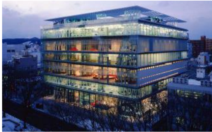
Fig 69 : Vue extérieur du projet.
