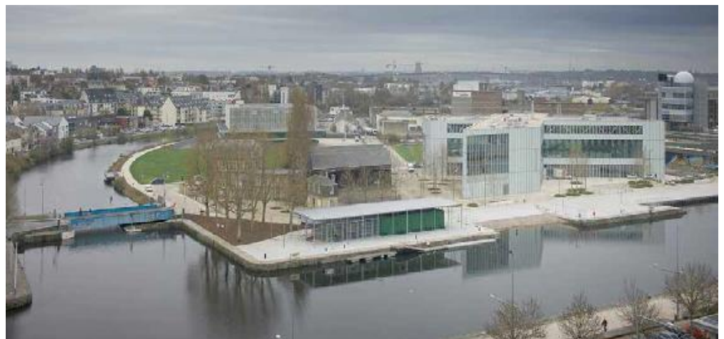
Fig 82: Vue d'ensemble du projet.
