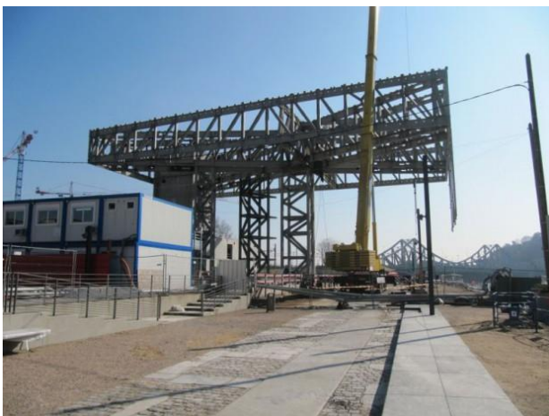
Fig 109 / 110 : Image en cours de construction des piles et des poutres métalliques. Source : www.batiactu.com .
