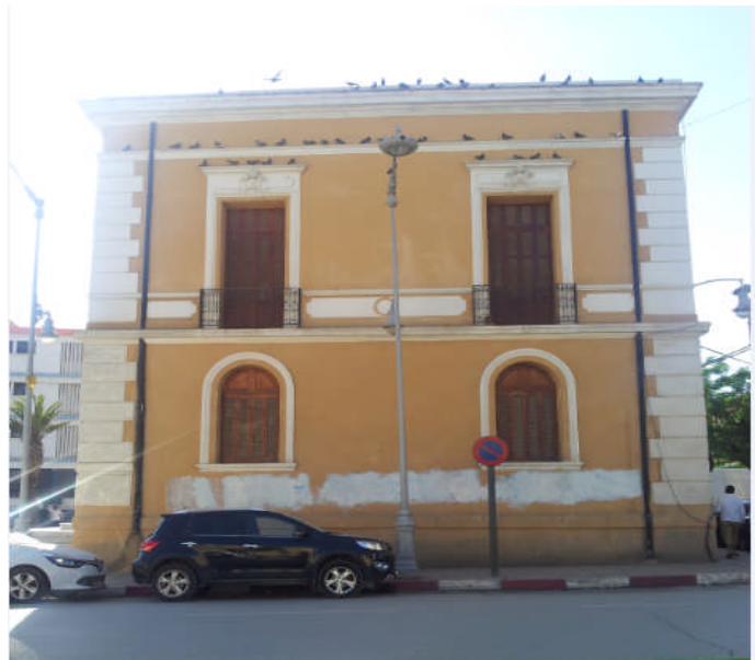
Figure III.6 : Vue de face gauche de la structure.
