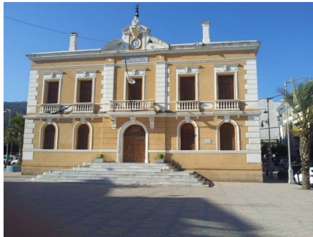
Figure III.2 : Exemple de construction en maçonnerie dans le centre ville de Tizi-Ouzou.
