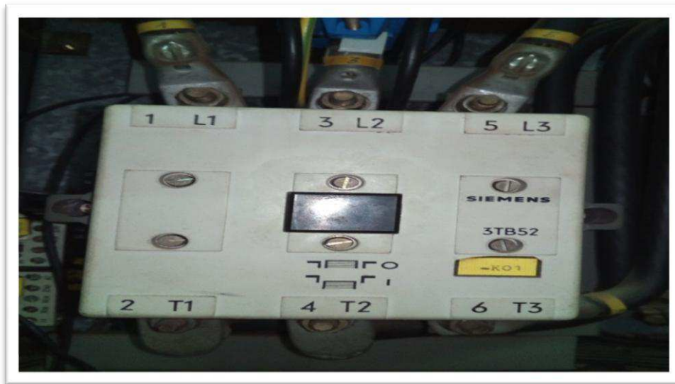
Figure II.5: Contacteur.
