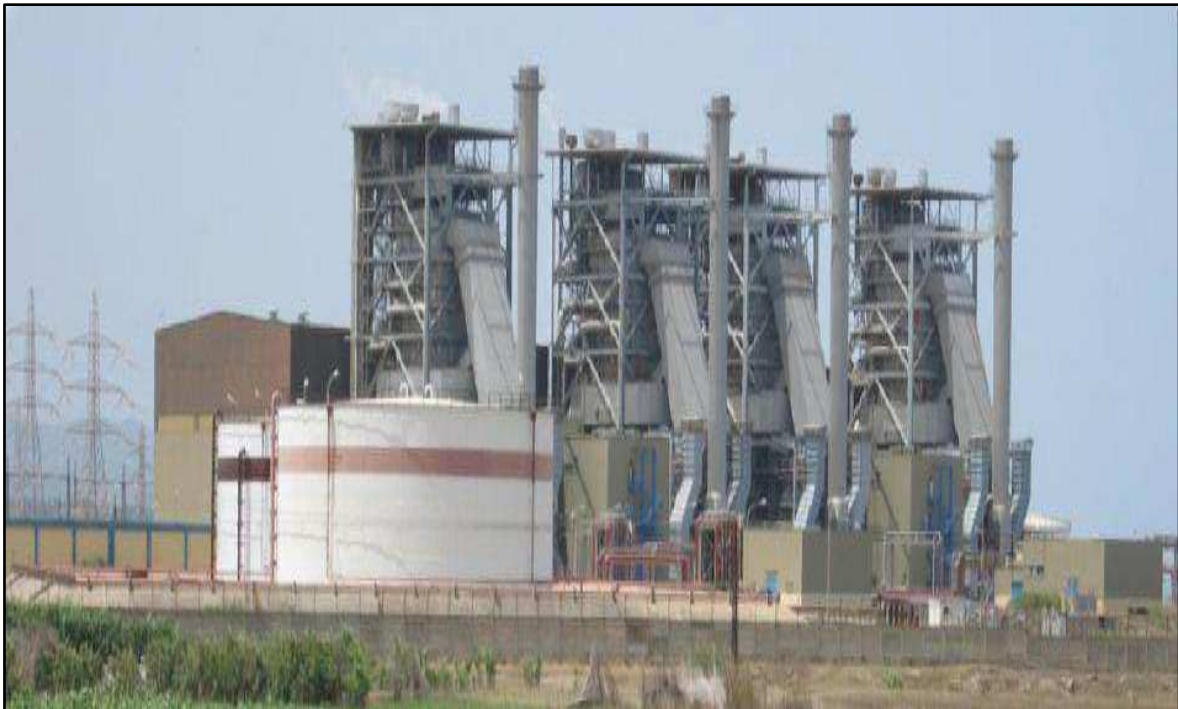
Figure I.1 : La centrale thermique de RAS-DJINET
