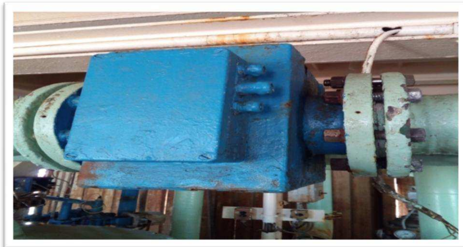
Figure II.8: Capteur de débit.
