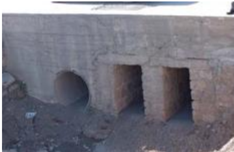
Figure 1.23 :Pont de la RN26 sous lequel s'écoule la branche douar riquet.(TOUAT,2004).
