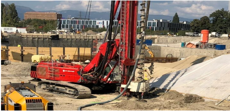
Figure II.24 : Technique de mise en œuvre d'inclusions rigides
