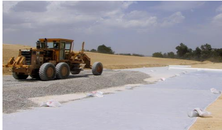
Figure II.9 : Renforcement par géotextiles
