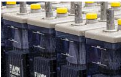
Figure 17 : Batteries solaire ouverte ou liquide
