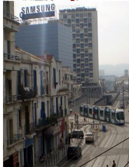
Figure58: état du bâti du côté des Abattoir
