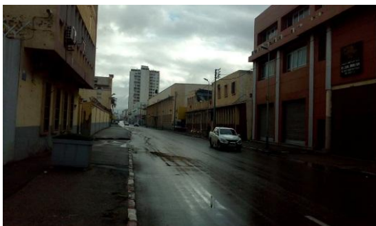
Figure59 : bâtis en moyen état du côté ouest du quartier
