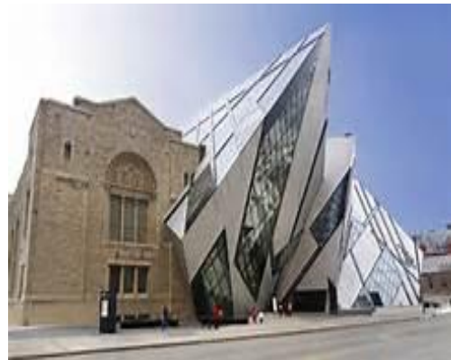
Figure 97 : extension à l'ancien bâtiment
