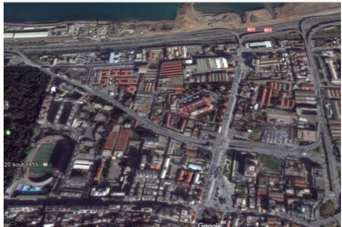
Figure35 : état actuelle du quartier des Annassers
