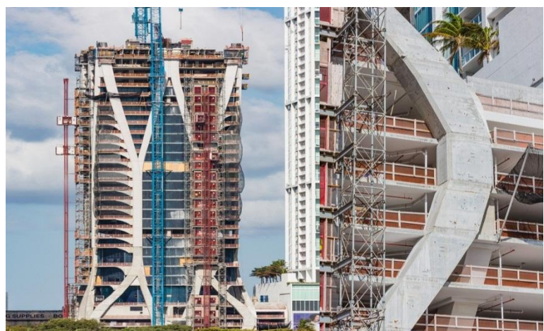
Figure 99 constructions des éléments en béton armé de fibre
