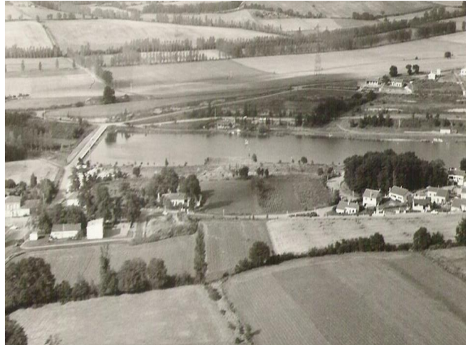
Figure 40 : Lac Flourens avant travaux de réaménagement
