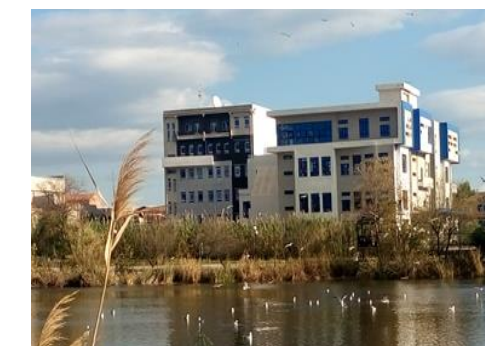
Figure 117 : Bibliothèque et maison de la radio Source : Auteurs
