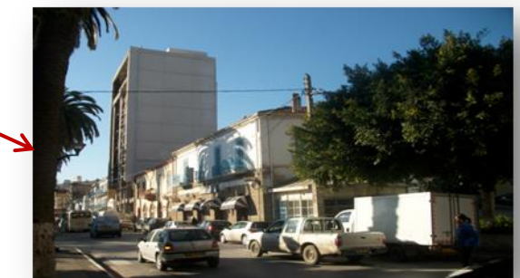
Figure 76 : Boulevard de la Soummam Source : Auteurs
