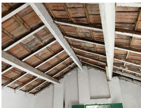
Photo 26 : Charpente du mausolée (Source : auteur)
