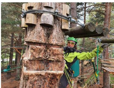
Photo 46 : Fixation des obstacles (Source : https://cataline-montage.com/2020/04/19/preserver-arbres-parc-accrobranche/ )
