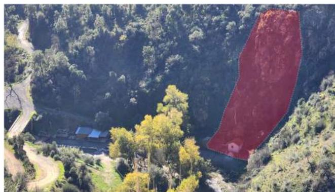
Photo 13 : Vue sur la zone exposée aux risques d'éboulements (Source : auteur)
