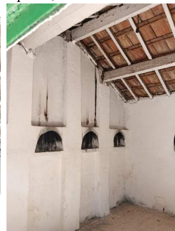
Photo 27 : Niches à bougies (Source : auteur)
