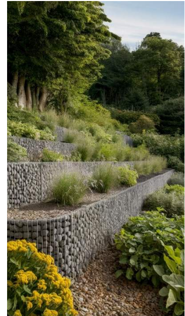
Photo 72 : Murs de soutènement en gabions (Source : https://fr.pinterest.com/pin/1196337404279808/ )
