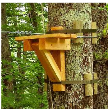
Photo 45 : Fixation des plateformes sur les arbres (Source : : https://duhautdemonarbre.fr/plateformes )
